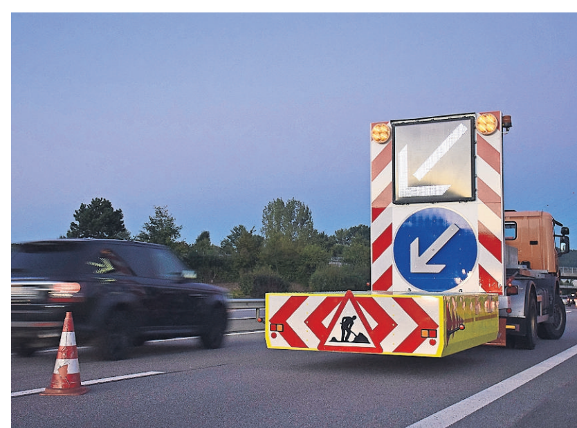
Nötig: Kurz bevor es dunkel ist, wird die rechte Spur abgesperrt.
