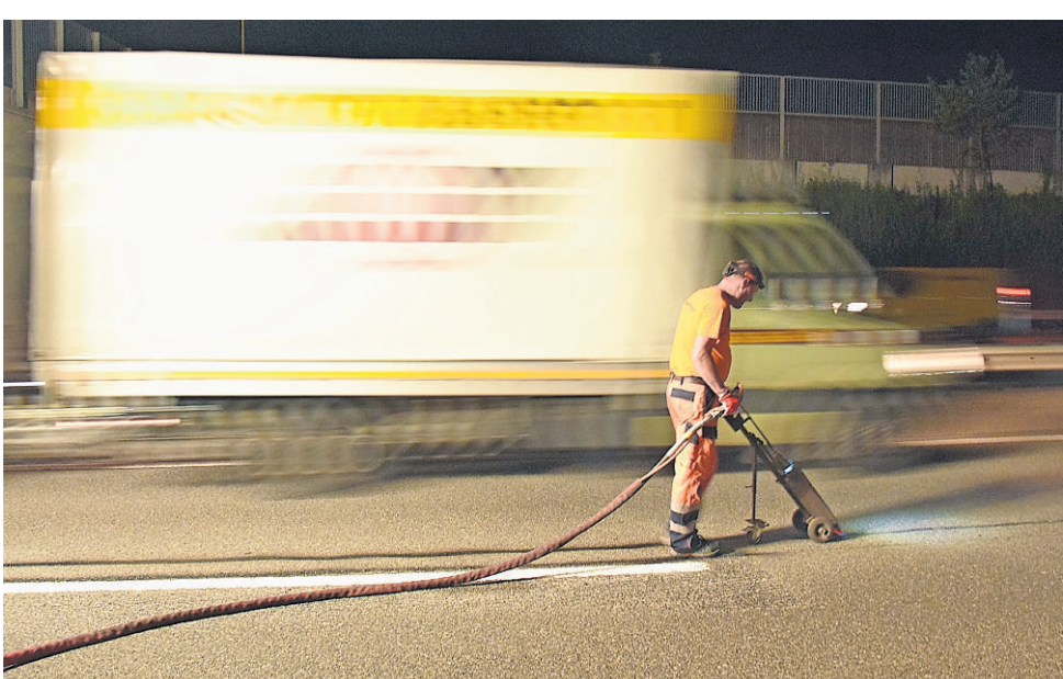
Surreal: Während der Arbeiter ruhig die Risse ausbessert, braust der Verkehr an ihm vorbei.
