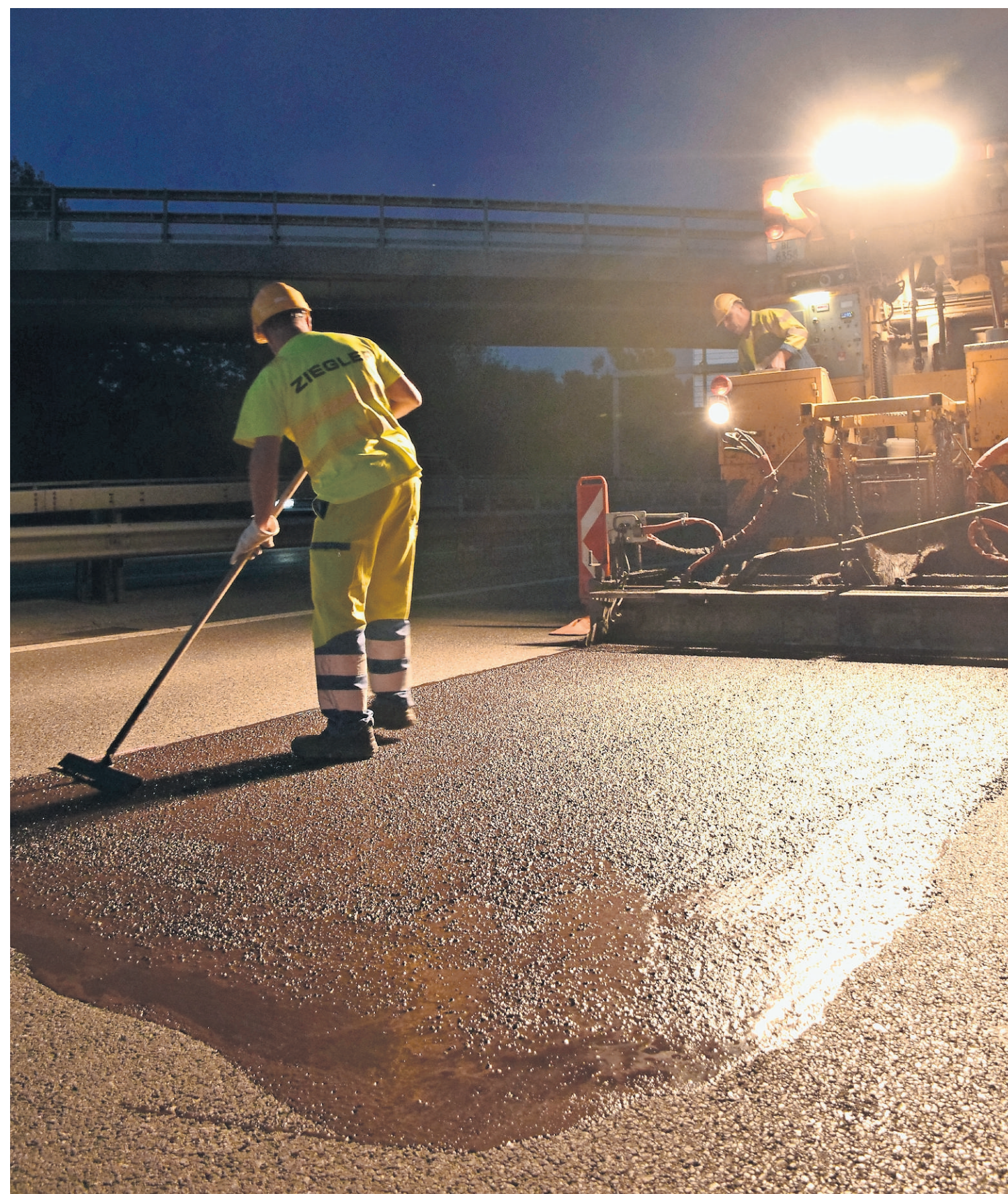
Der Verleger, ein Ungetüm mit Bitumenmischer, trägt die Asphaltdeckschicht auf, deren Ränder von den Arbeitern glattgestrichen werden.
