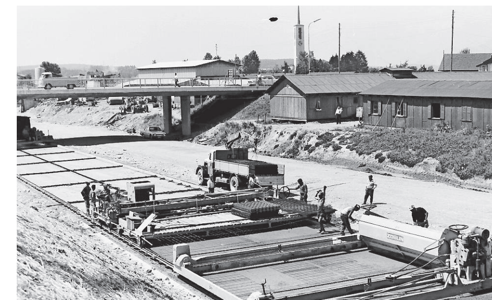
Belagseinbau auf der N1 in Oftringen, im Hintergrund die Kirche. ARCHIV MAX.ROTH
